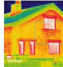
Hoher Energieverlust bei einer ungenügend gedämmten Fassade
