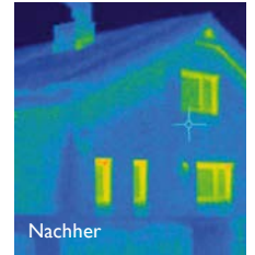
Effizient gedämmte Cedral Fassade mit hohem Energie-Einsparpotenzial
